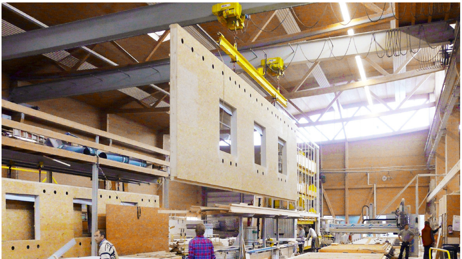
Abb. 2: Vorfertigung eines Fassadenelementes
