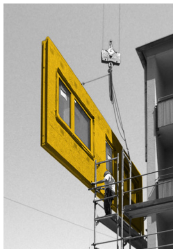
Abb. 76: Einfädeln des Fassadenelements zwischen Bestand und Gerüst
