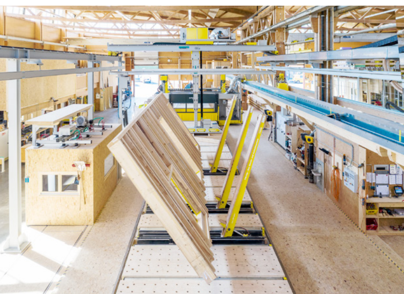
Abb. 7: Elementfertigung im Werk
