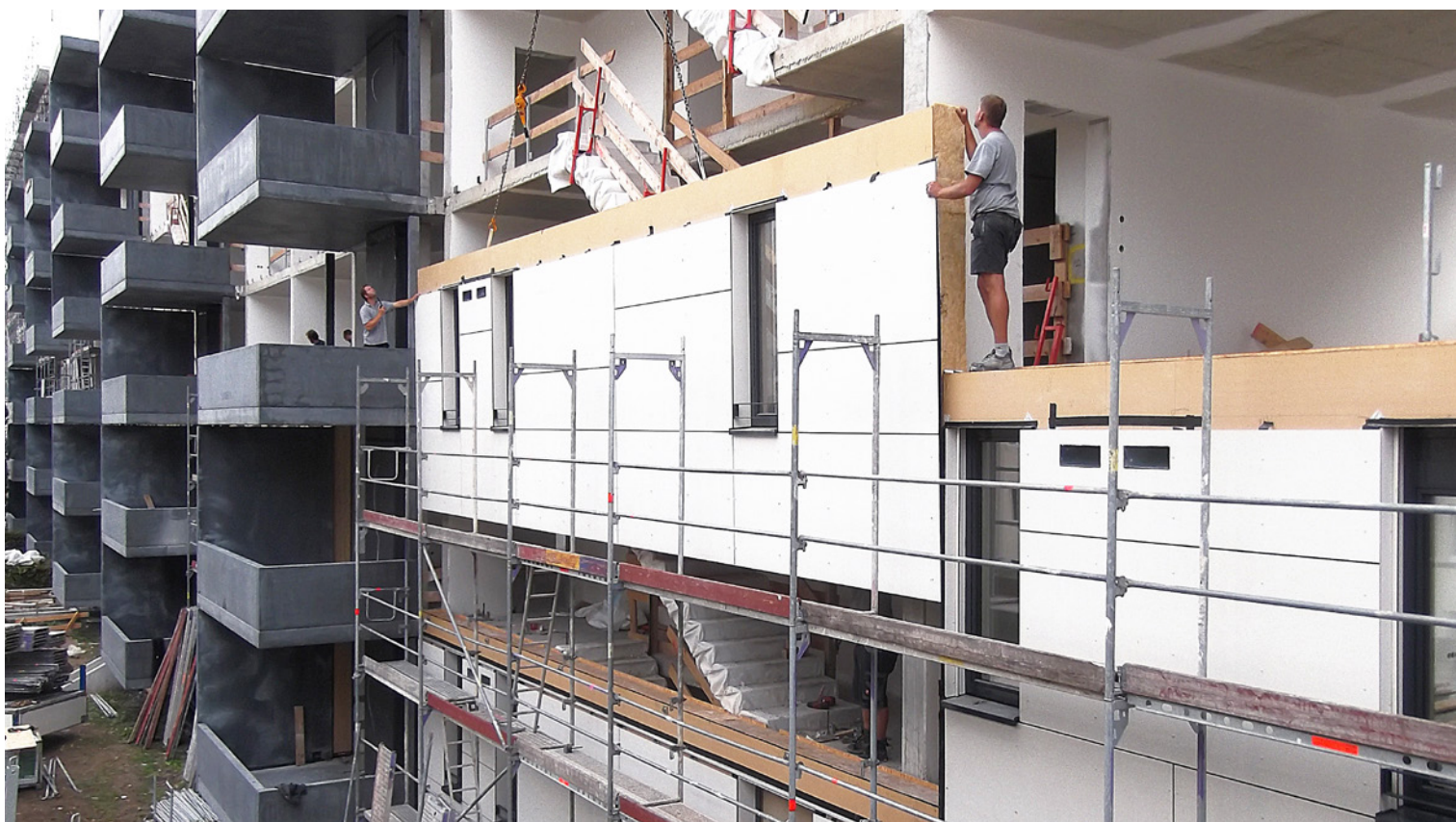
Abb. 3: Montage eines vorgefertigten Fassadenelementes
